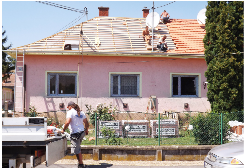
Tetőfedés, majd szigetelés - új köntöst kap az önkormányzat épülete
